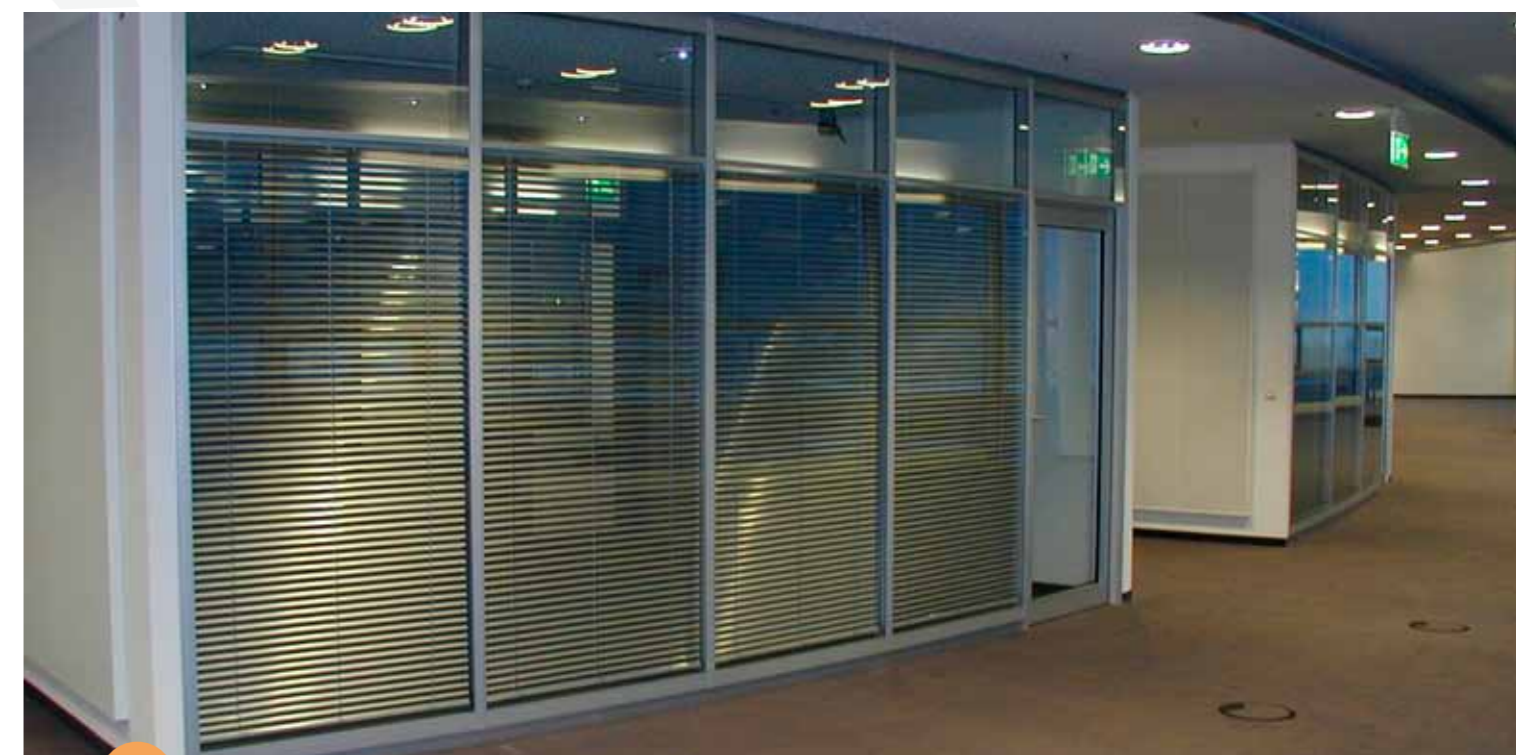
Horizontaljalousien mit Elektroantrieb zwischen den Gläsern integriert.
