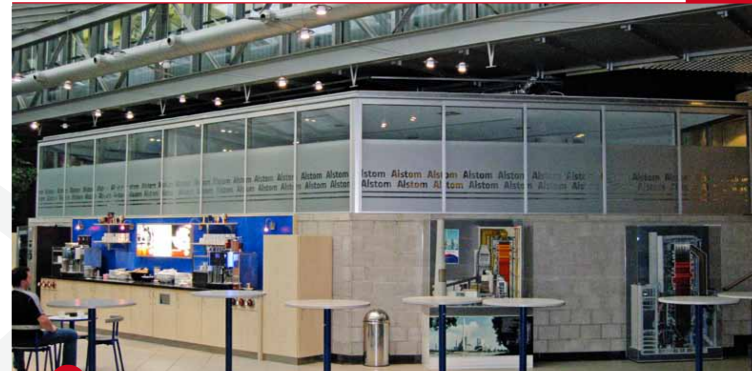
Glaswände aufgesetzt auf eine Betonbrüstung. Folierung mit Firmenlogo.
