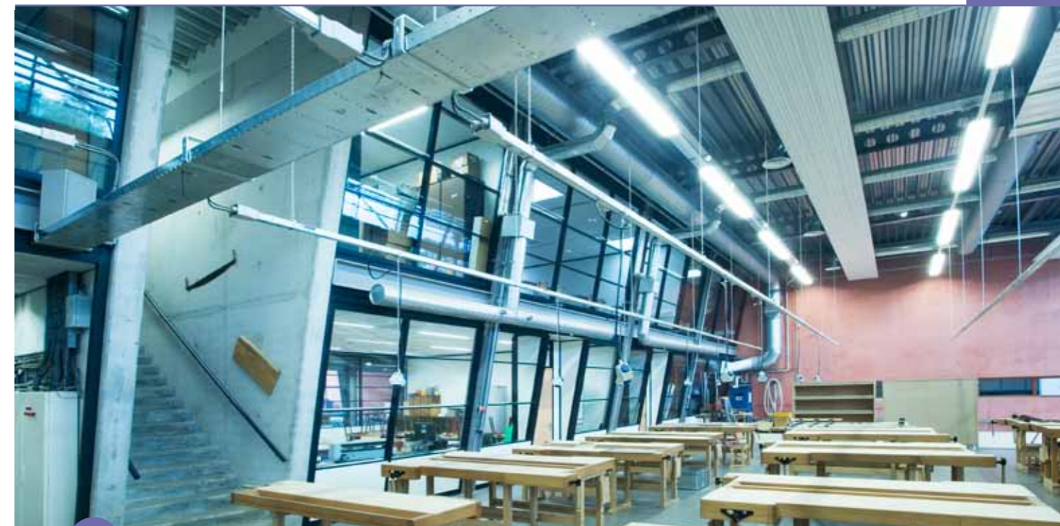
Hoher Schallschutz und maximale Transparenz durch Glaselemente mit Schallschutzverglasung.
